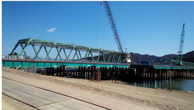
【(国)398号 新北上大橋 上部工架設工事状況】
