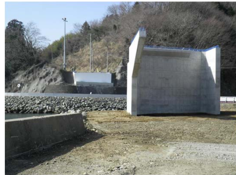
【(国)398号 相川橋 下部工工事完成状況】
