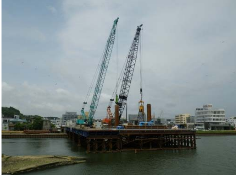
【(国)398号 内海橋 下部工工事状況】
