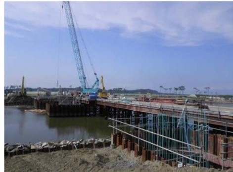
【(一)石巻松島自転車道線 浜市橋 下部工工事状況】
