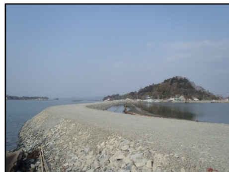
【東名海岸の工食用道路築造完了】
