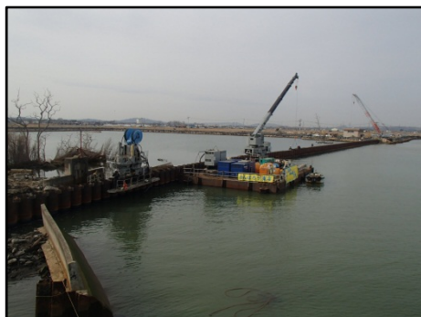
【定川破堤部の鋼管矢板打設完了】
