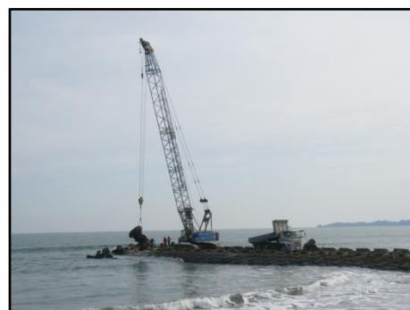
【大曲海岸のブロック据付状況】
