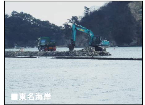
【東名海岸の工事用道路築造状況】
