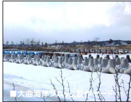
【大曲海岸のブロック製作状況】
