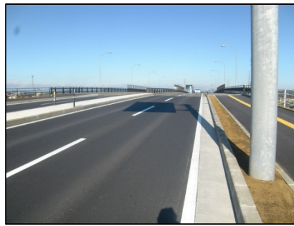
(一)河南石巻港インター線 東松島市赤井地内
