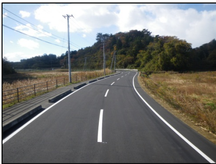
(主)奥松島松島公園線 東松島市宮戸地内
