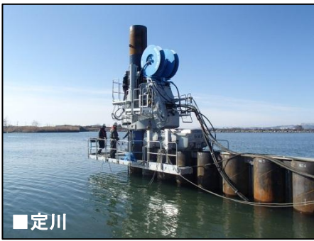
【定川破堤部の鋼管矢板打設状況】
