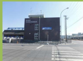
津波浸水表示板
