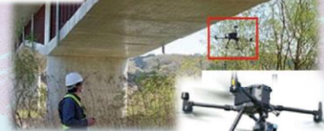
ドローンを活用した点検
