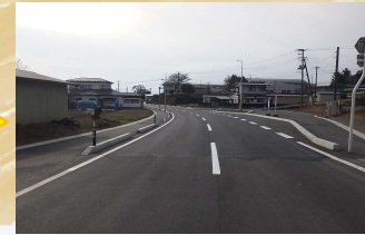
通学路の歩道整備後
