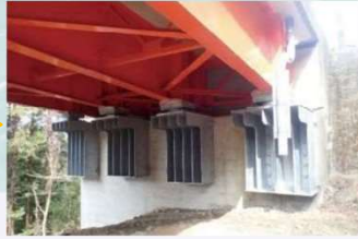
橋梁耐震化工事後
