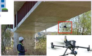
ドローンを活用した点検
