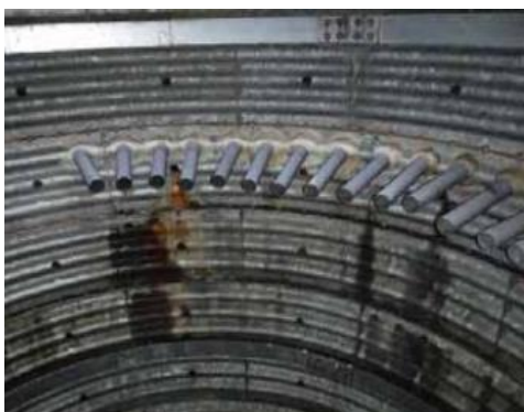
図 3.1 水抜きボーリング
