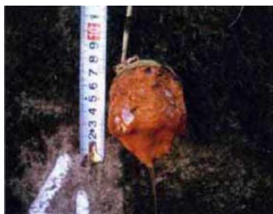
図 3.4 集水ボーリング工の閉塞
