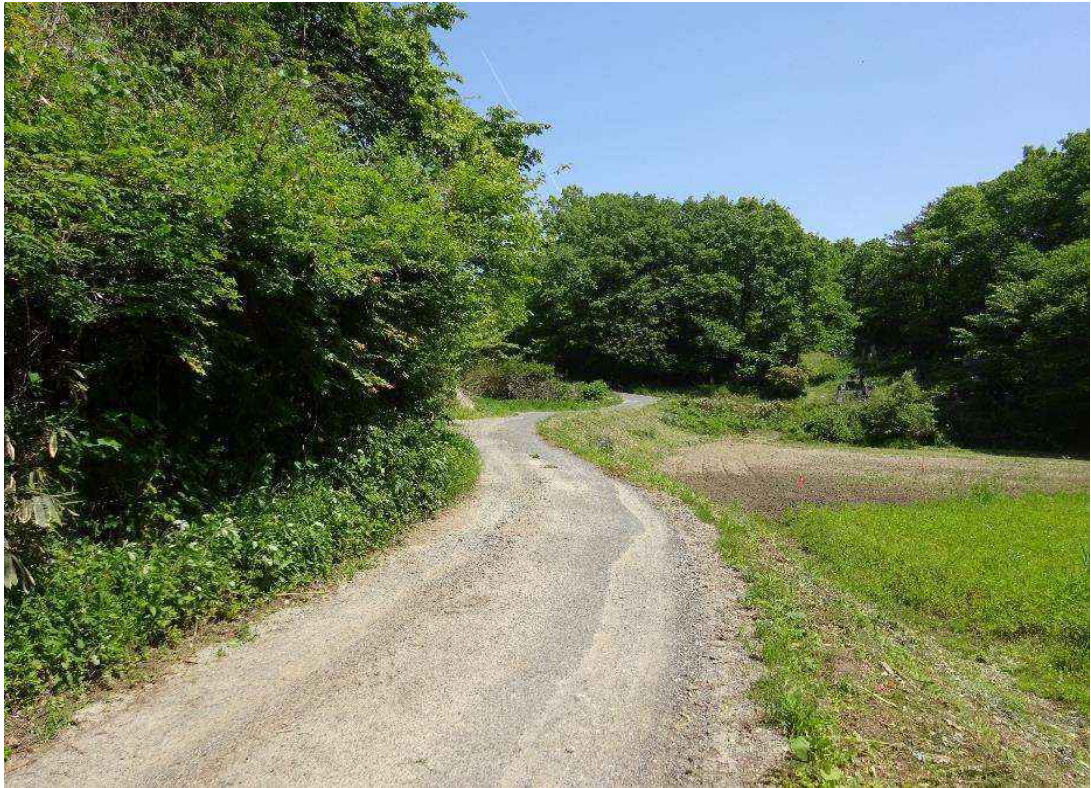
幅員狭小、蛇行路線状況
