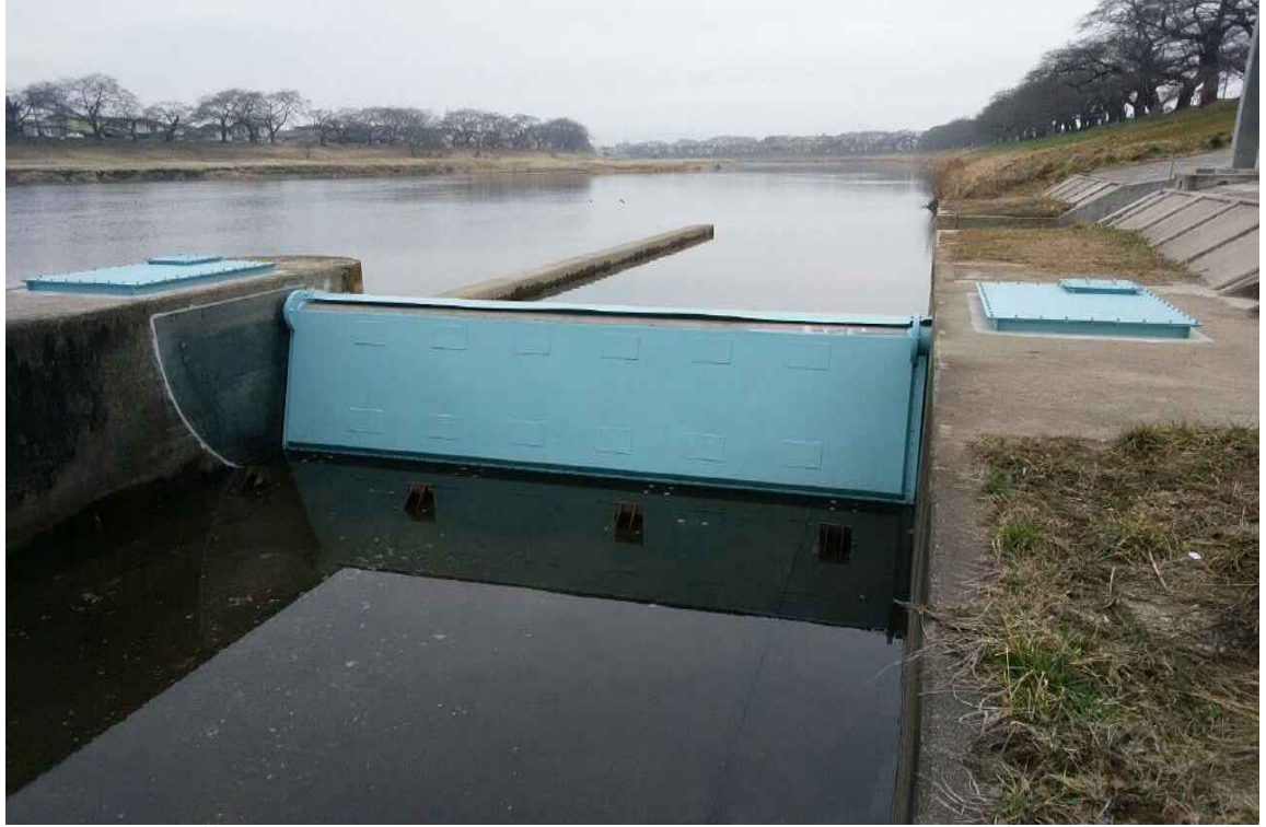
土砂吐ゲート(整備後)
