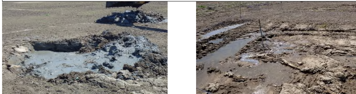
地下水位が高いことによるほ場の不良地盤状況、湧水状況等
