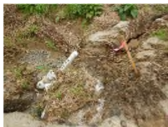
写真：用地杭流失状況
