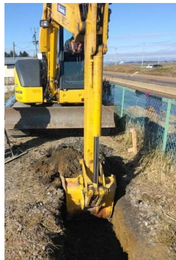
R5工事施工状況
