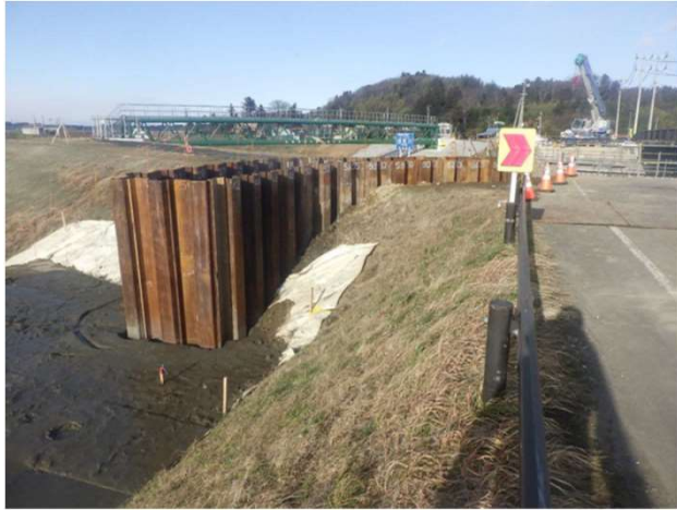
古い水道管の撤去工事状況
