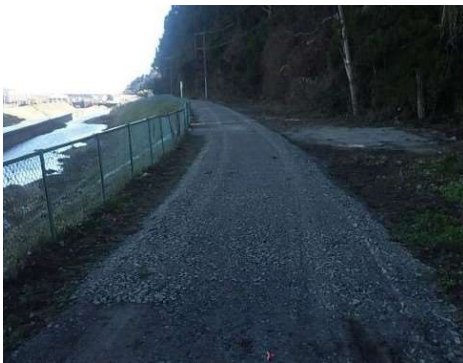
工事完成状況
