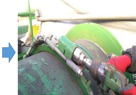
ボルト交換作業中
