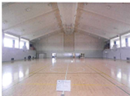
講堂天井改修（着手前）
