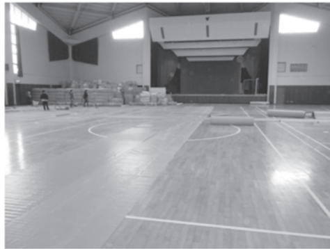
写真2-1 アリーナ内の物資を移動し、通路の確保から開始
