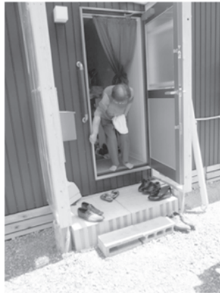
写真4-1 応急仮設住宅の玄関の例
