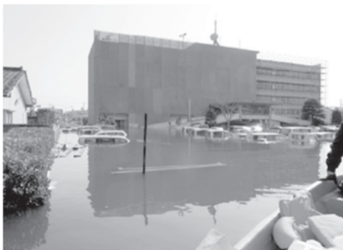
写真1 被災した合同庁舎
