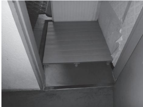
浴室入り口の段差の解消 車いすの介助者も可能に
