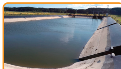
農業水路等長寿命化・防災減災事業 R3 桑折江3期地区(ため池遮水シート布設)
