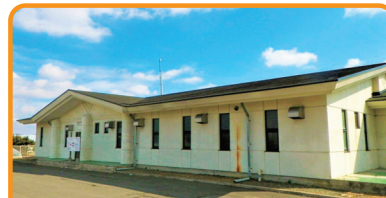
農業集落排水事業 南郷第3地区
