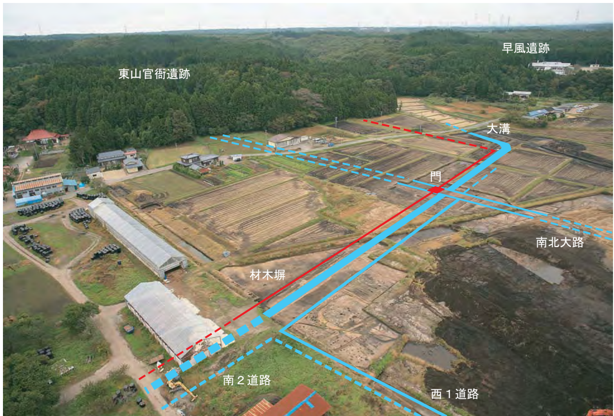
東山官衙遺跡正面の区画施設と道路の状況（南西から）
