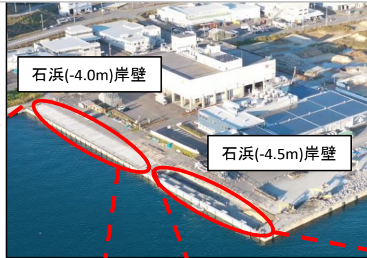
施工状況【石浜（-4.0m）,（-4.5m）物揚場】
