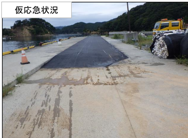
エプロン部の沈下
