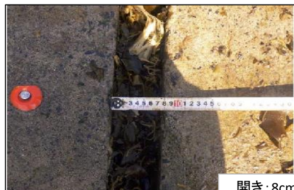
エプロン中央部の沈下による排水不良
