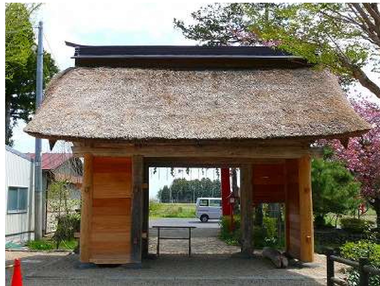
大宮寺山門 背面写真（令和2年度屋根修復工事前）
