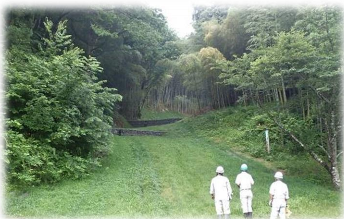
丸森町耕野字入大地区（工事完成）
