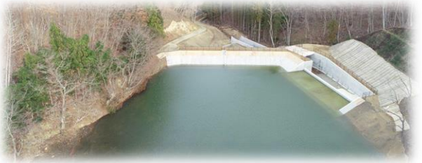
長柴山（復旧後）（農業用ため池）
