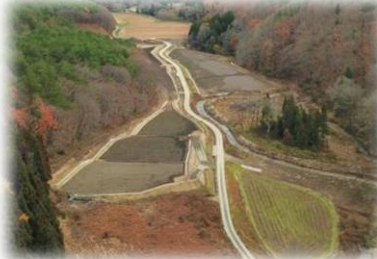
七ヶ宿町田堀分区（工事完了後の状況）
