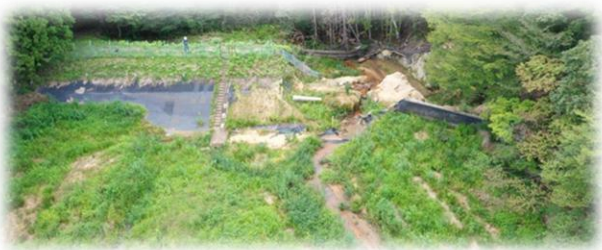
長柴山（復旧前）（農業用ため池）
