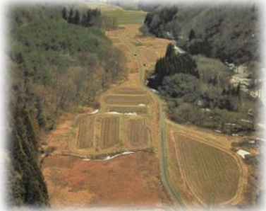
七ヶ宿町田堀分区（工事着手前の状況）
