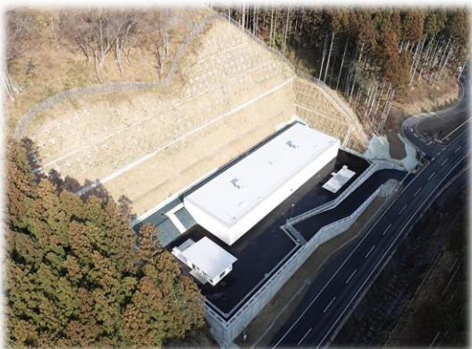
完成した姥ヶ懐調整池（村田町内）
