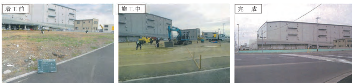
16 街区 1 画地の保留地復旧状況
