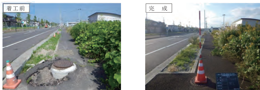
高砂駅蒲生線 下水道災害復旧状況
