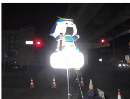
むすび丸の夜間工事照明
