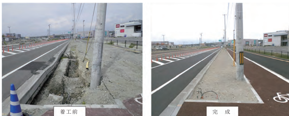
応急復旧状況（海の見える大通り線）
