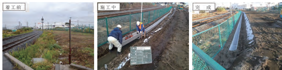
4号緑地 排水フリューム修繕状況
