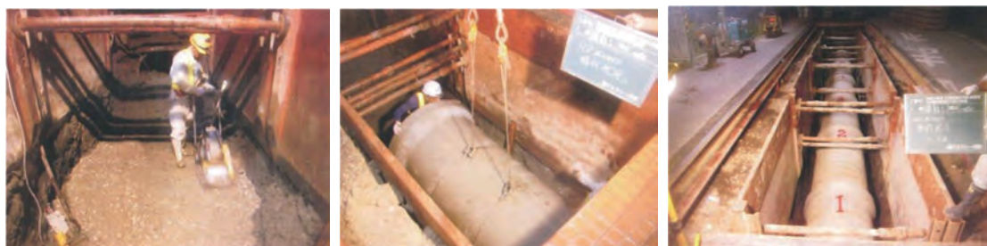
工業地区 下水道災害復旧工事夜間施工状況
