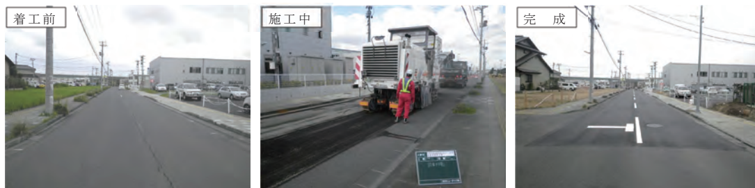
区画道路12-18 センタークラック補修状況
