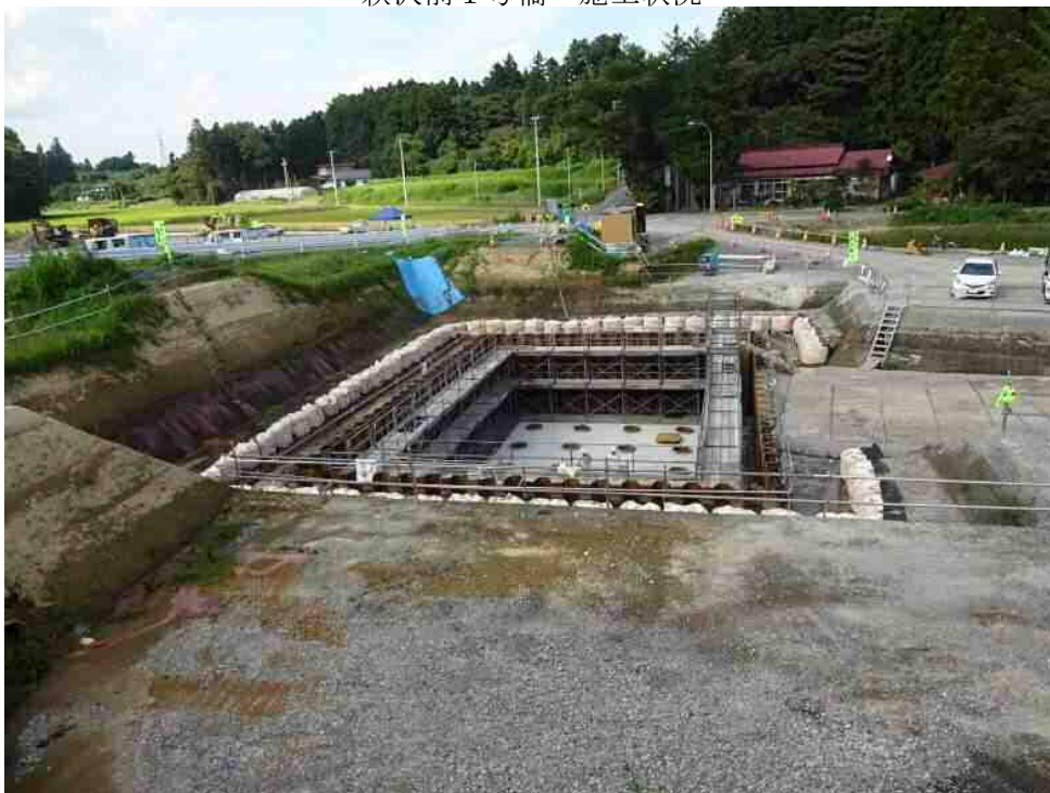
萩沢忽滑沢本線橋 下部工 施工状況
