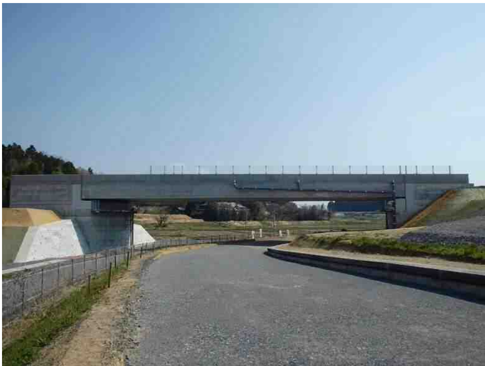
萩沢前2号橋 施工状況
