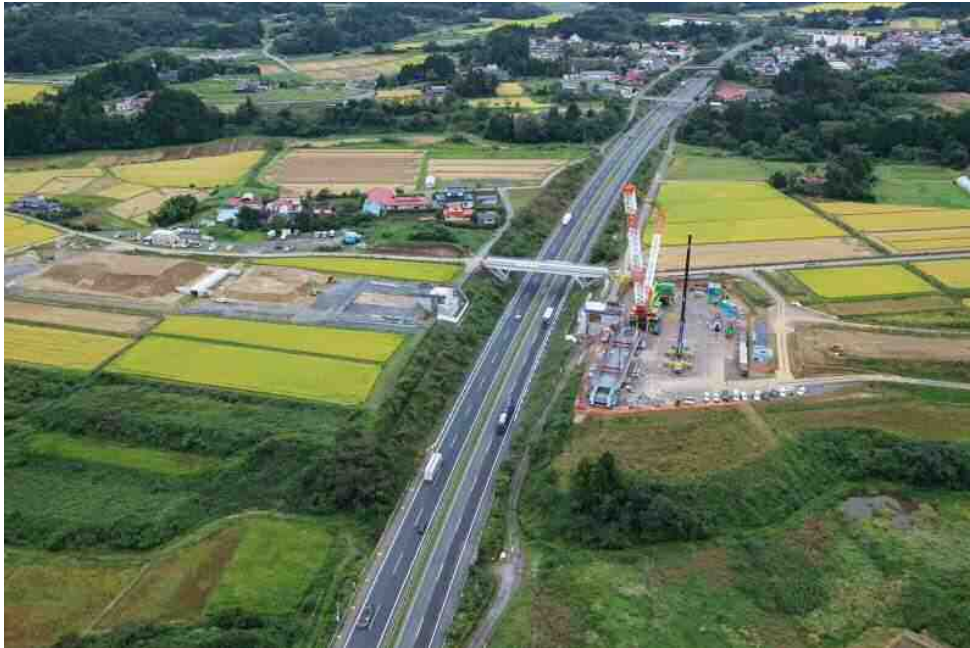
後沢本線橋 上部工施工状況 (東北自動車道横過部)
