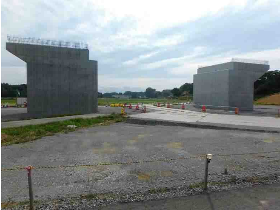
萩沢前1号橋 施工状況
