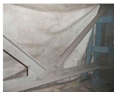
桁端部の重防食塗装
