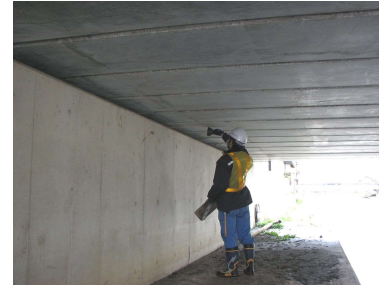
定期点検の状況
