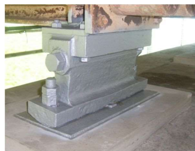
鋼製支承の金属溶射
