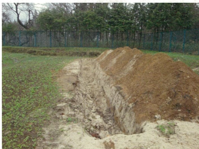
図 1 鋤込まれている箇所の様子。図中の土の盛っている箇所の下方、地下約 1 m に鋤込んでいる。土盛りの左側の溝は、鋤込んだ場所と同じ深さの溝を作製した。
