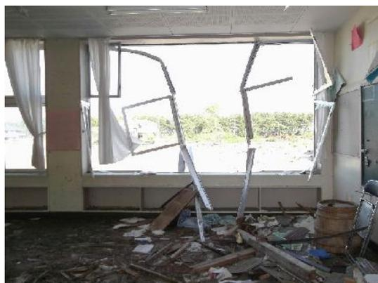
2階の西側教室に津波が直撃し窓枠破壊
