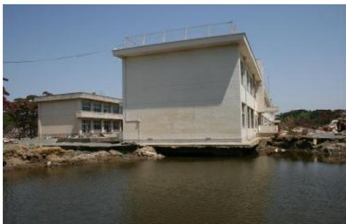
南校舎の側面（南西）は陥没して浸水
