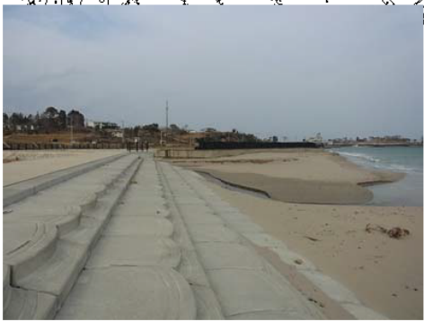
参考写真：大谷海岸：階段ブロック (1:3.0) ※左：側面、右：正面
