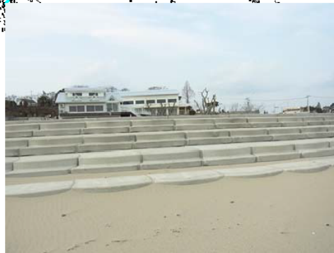
参考写真：大谷海岸：階段ブロック (1:3.0) ※左：側面、右：正面
