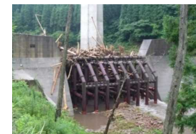
透過型砂防堰堤による流木捕捉事例
