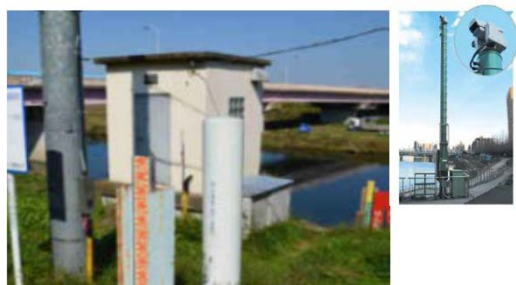
水位計・河川監視カメラ等の整備状況
