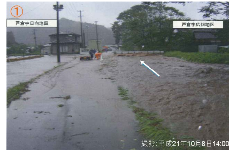
平成21年10月台風第18号で越水した西戸川
