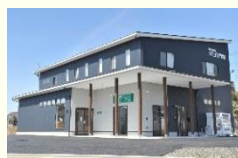
沿岸部交流人口拡大モデル施設整備事業（石巻市：MEET門脇）
